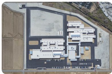
上空からの全景
